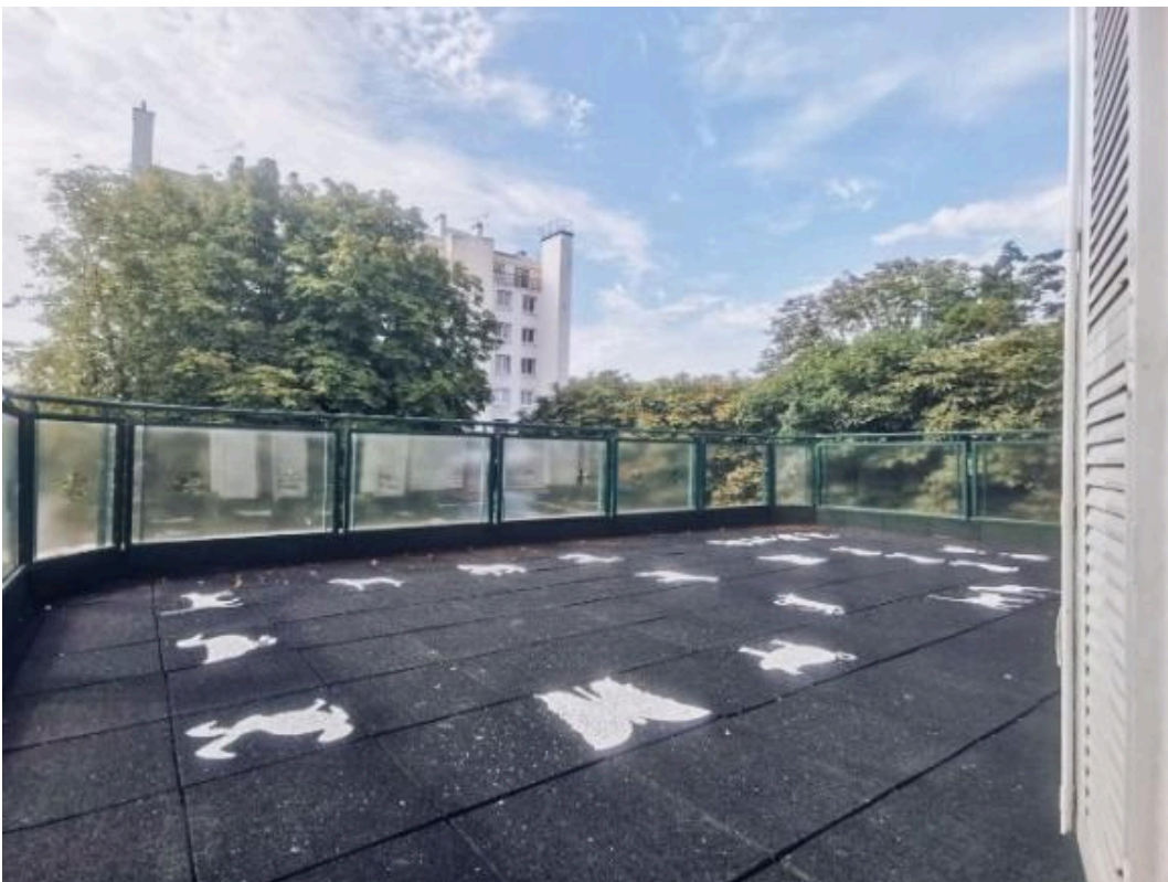
Vue sur la terrasse depuis la pièce coworking
