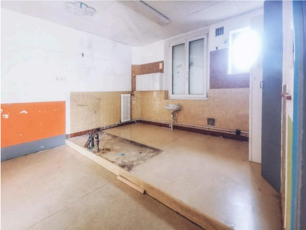
Salle traversante avec point d'eau.
